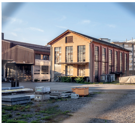
Das «Rote Haus» bleibt erhalten. Die schöne Industriehalle soll zu einem Treffpunkt werden.
